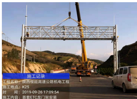
绥延高速首套门架安装
