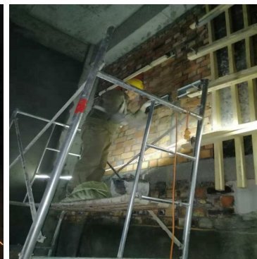
机场线 T5 航站楼 配套工程有序推进
